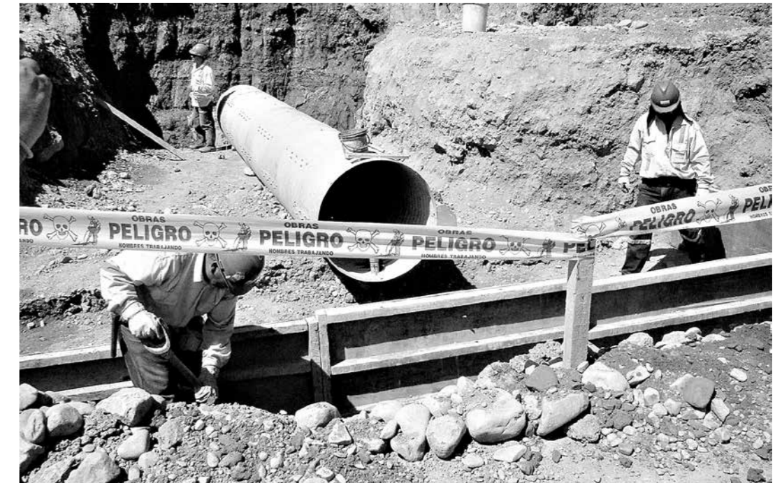
CUANDO RECIÉN COMENZARON LOS TRABAJOS.
