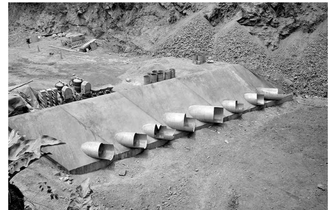
TRABAJOS INICIALES PARA LA PRESA TRONERA SUR.
