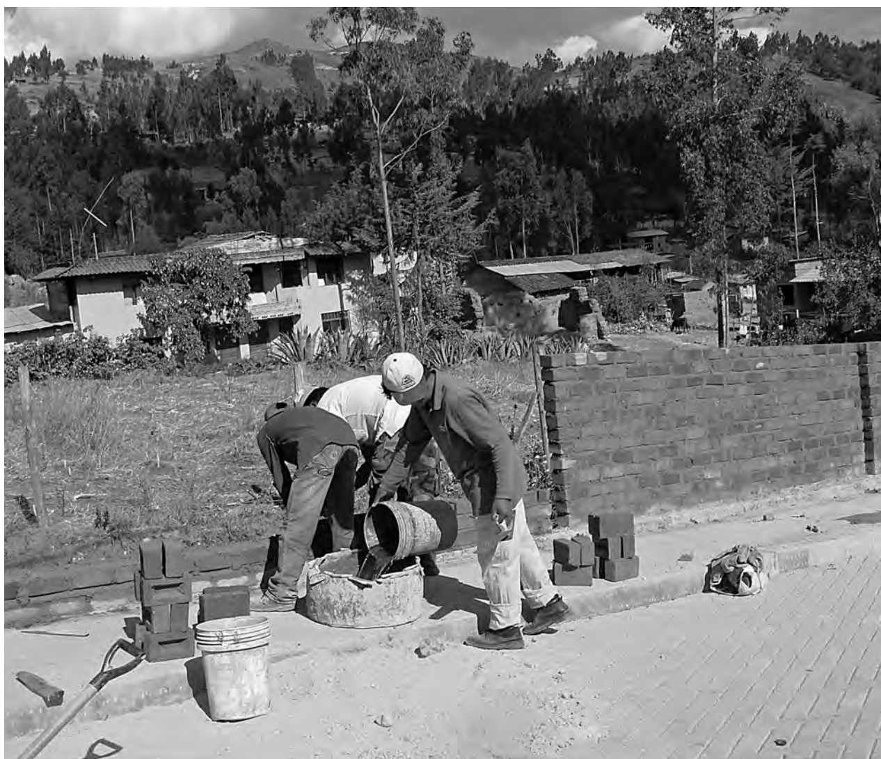
Como resultado de la vigilancia, comienzan los trabajos de construcción del muro perimétrico
