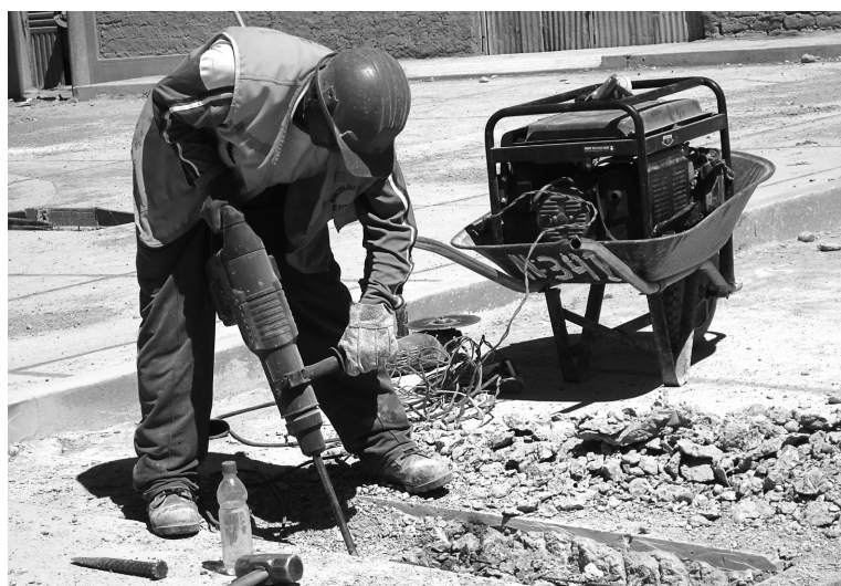
Reparando las fisuras identificadas por el comité de vigilancia
