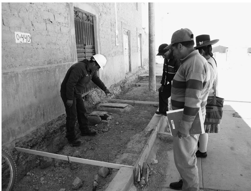
Arreglos de la berma
