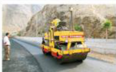
CARRERA. Obras de infraestructura vial en las regiones.
