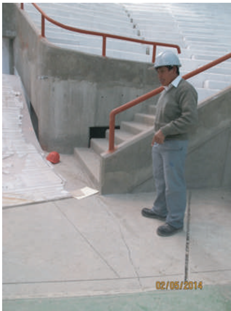
Presidente del Comité mostrando las fisuras halladas en las graderías y veredas externas del coliseo. Fisura en las bermas externas del coliseo
