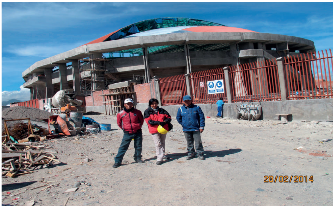
Coliseo en construcción. Febrero del 2014.
