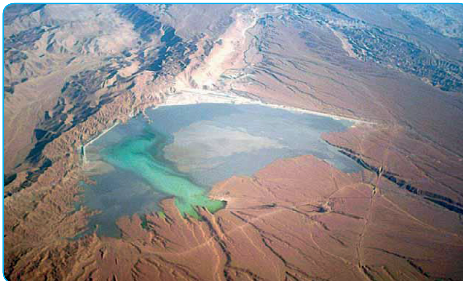
FOTOGRAFÍA N° 1. REPRESA DE RELAVES QUEBRADA HONDA, 2014
