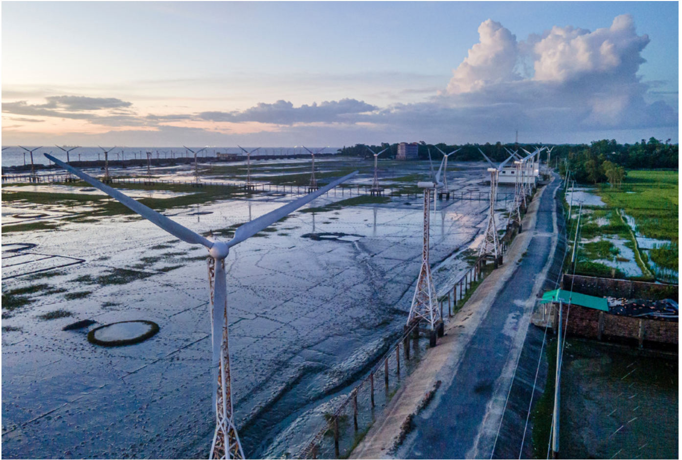
Photo: Vista de la central eólica de Kutubdia, Bangladesh.
