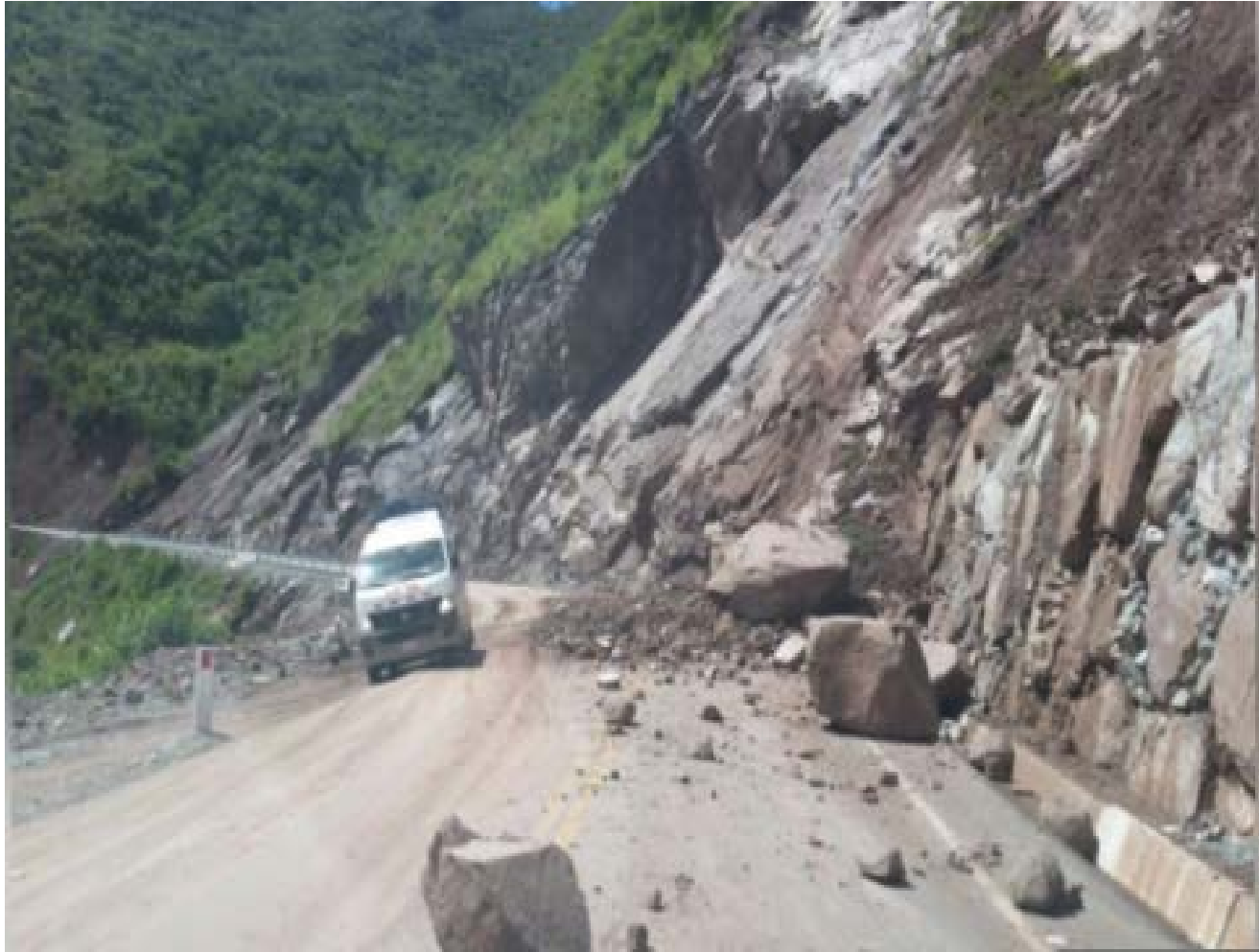
Caídas sobre carretera central enero 2017 (Selva Central)
