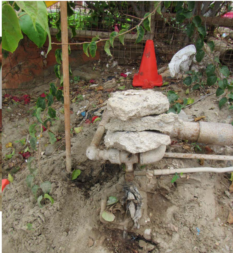
Pozo abandonado, con conexiones clandestinas por parte de los pobladores
