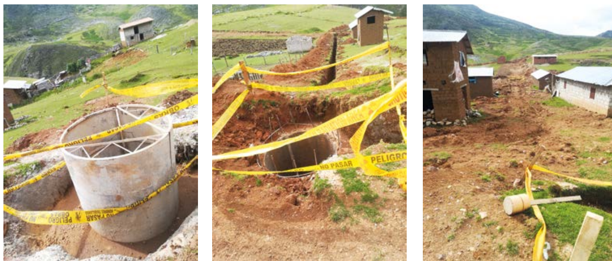
Imágenes del proceso de las obras de saneamiento encontradas durante la visita.
