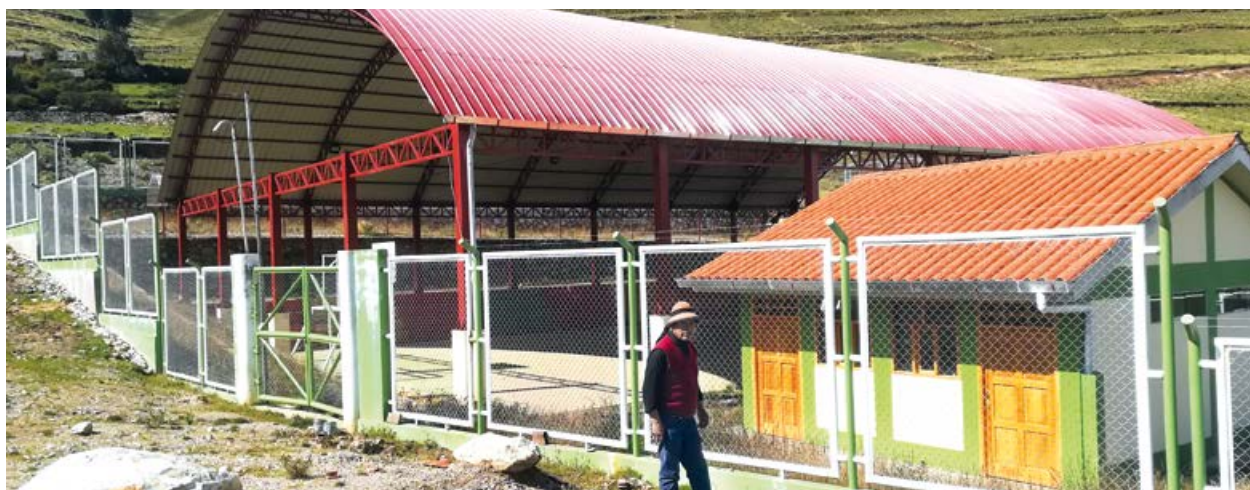
Losa deportiva multiuso en el anexo de Añoccalla. Centro Poblado de Asaccasi, distrito de Tambobamba.
