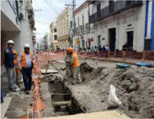
Selección por tamiz de material propio para relleno de zanjas
