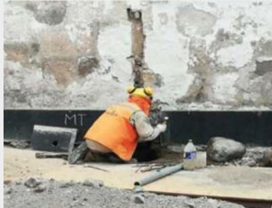
Picado y resane en muros para conexiones domiciliarias
