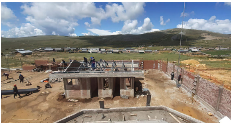
Foto N° 01: Proceso de ejecución del proyecto
