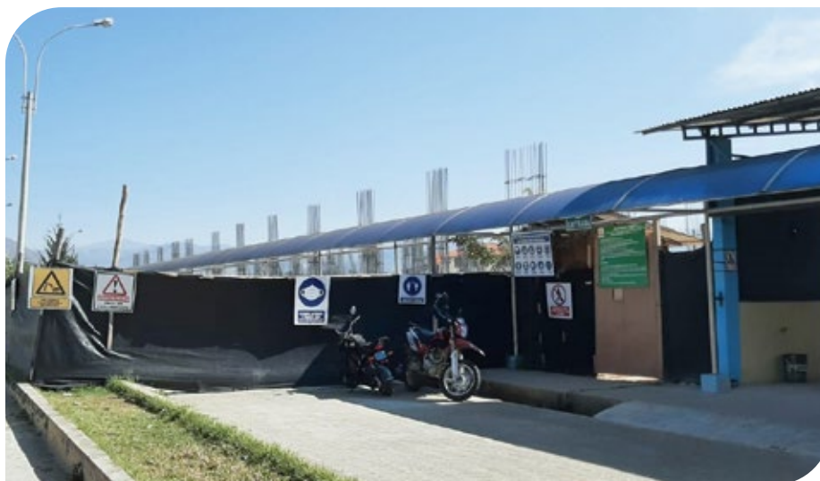
Puerta de ingreso a la obra
