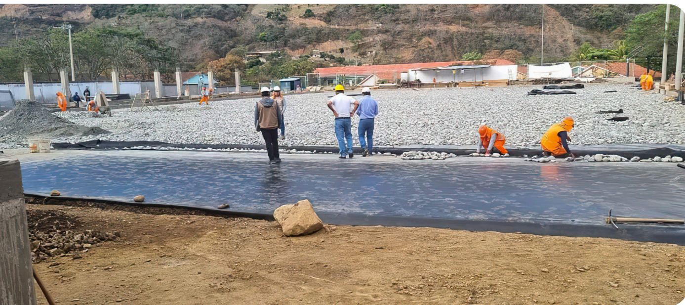
Visita a la obra
