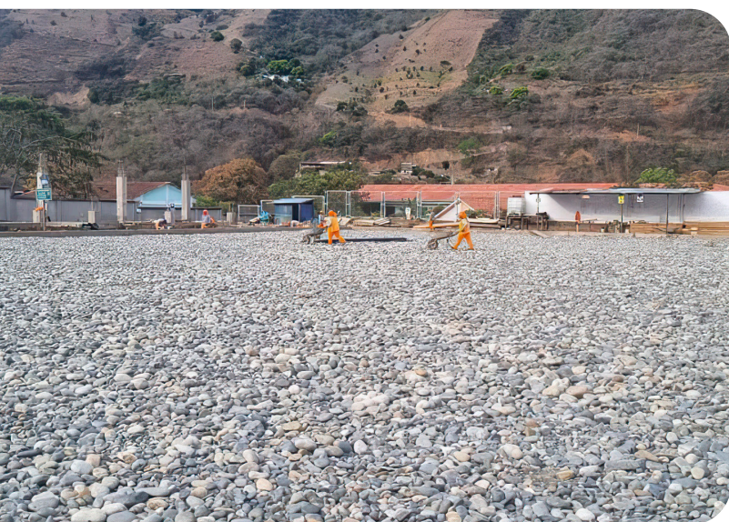
Nivelación de terreno para campo deportivo
