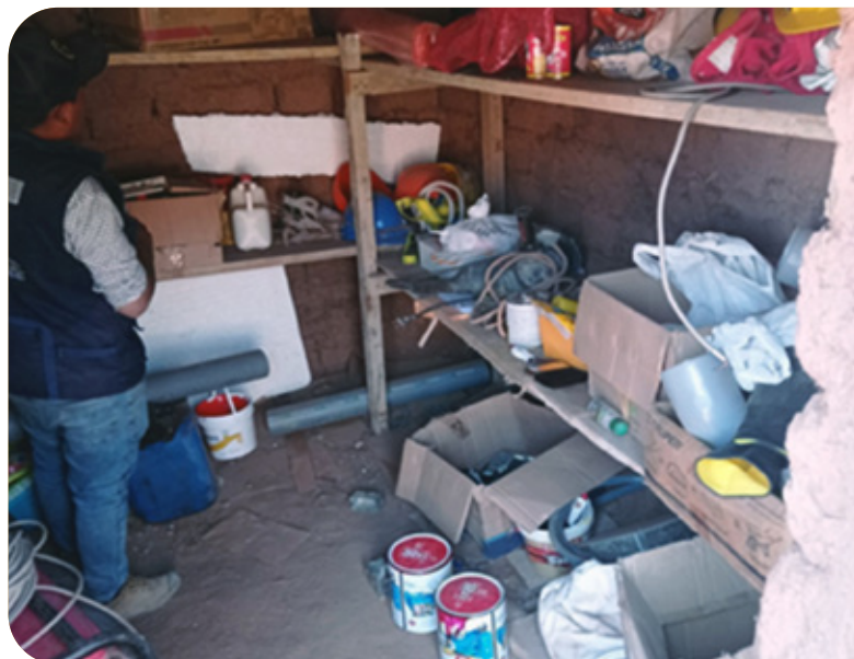
Interior de la obra
