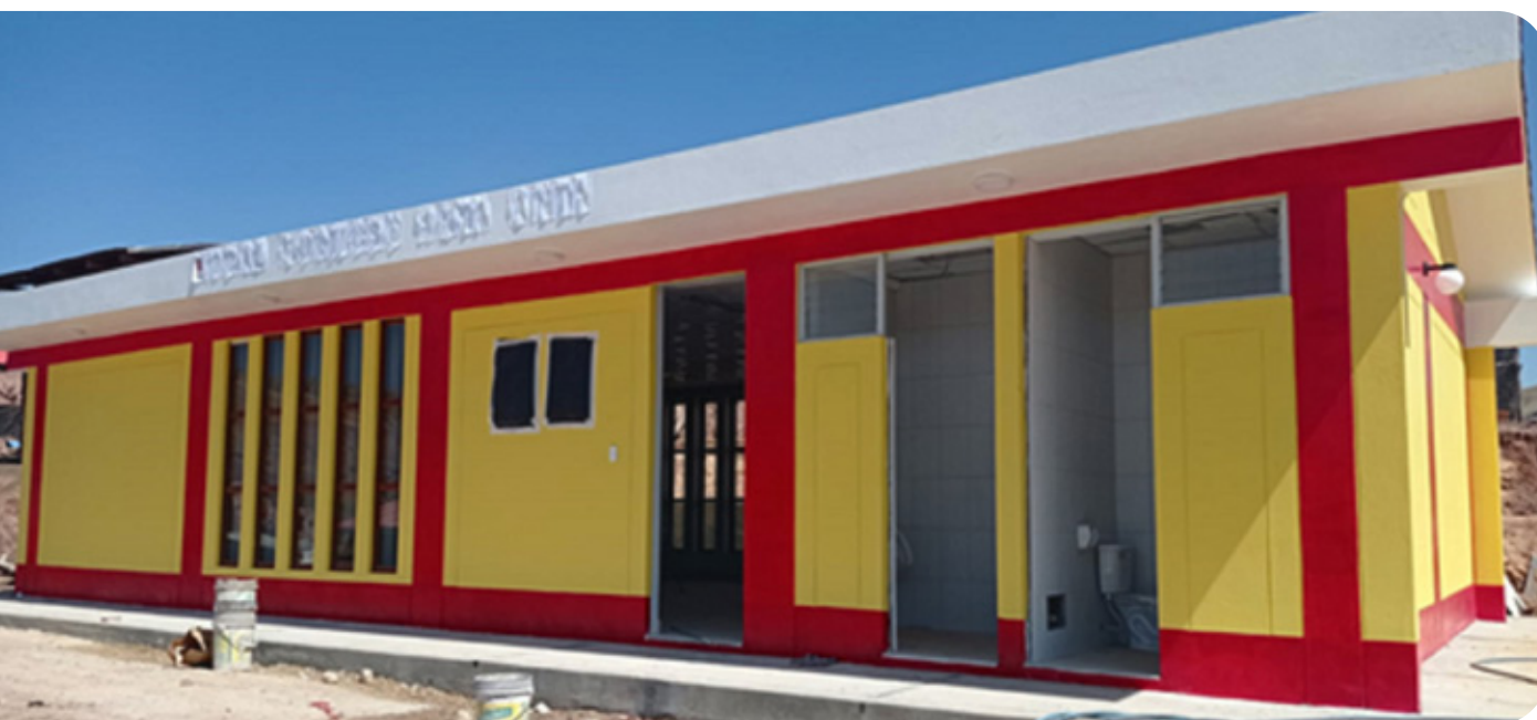
Avance de local comunal
