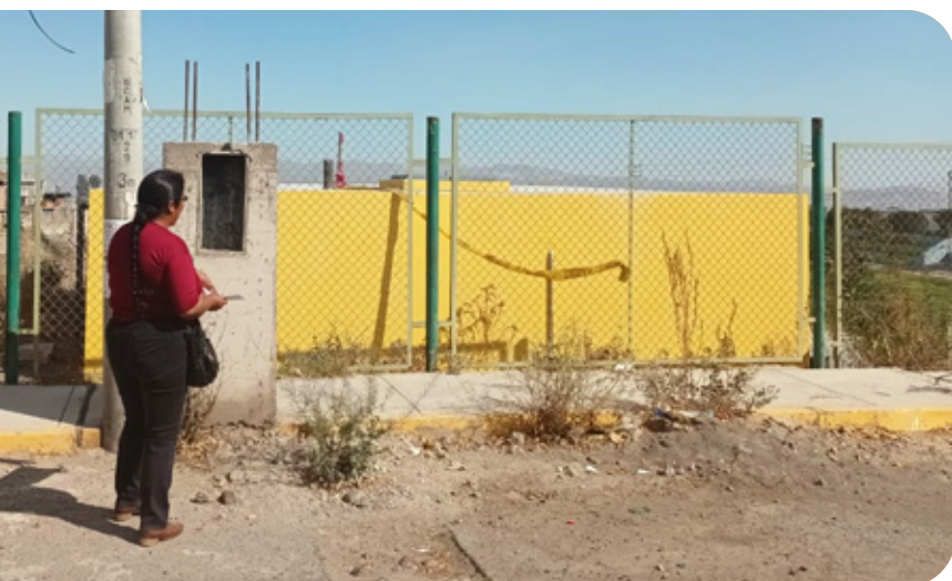
Visita a la obra en estado de abandono
