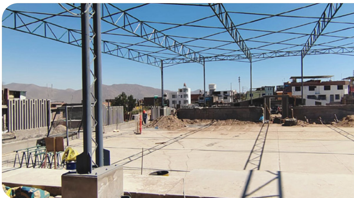
Estructura del techo del campo deportivo
