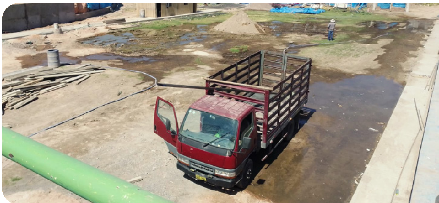
Remoción de tierra en campo deportivo
