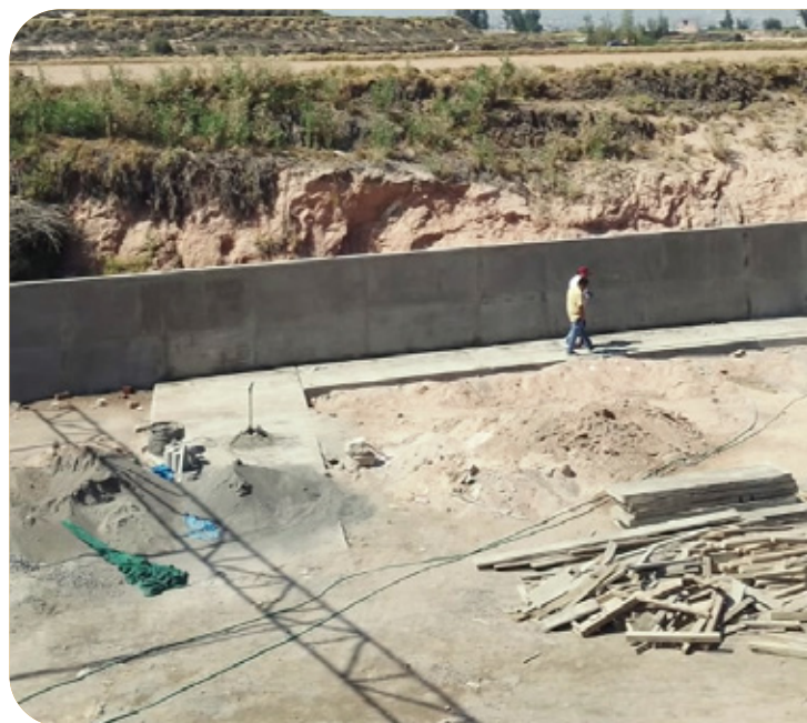
Muro colindante de la obra con la familia Tapia
