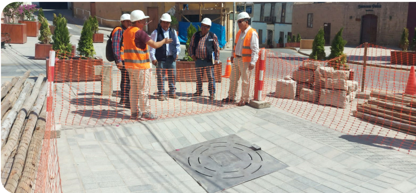
Avance de obra y juego de aguas
