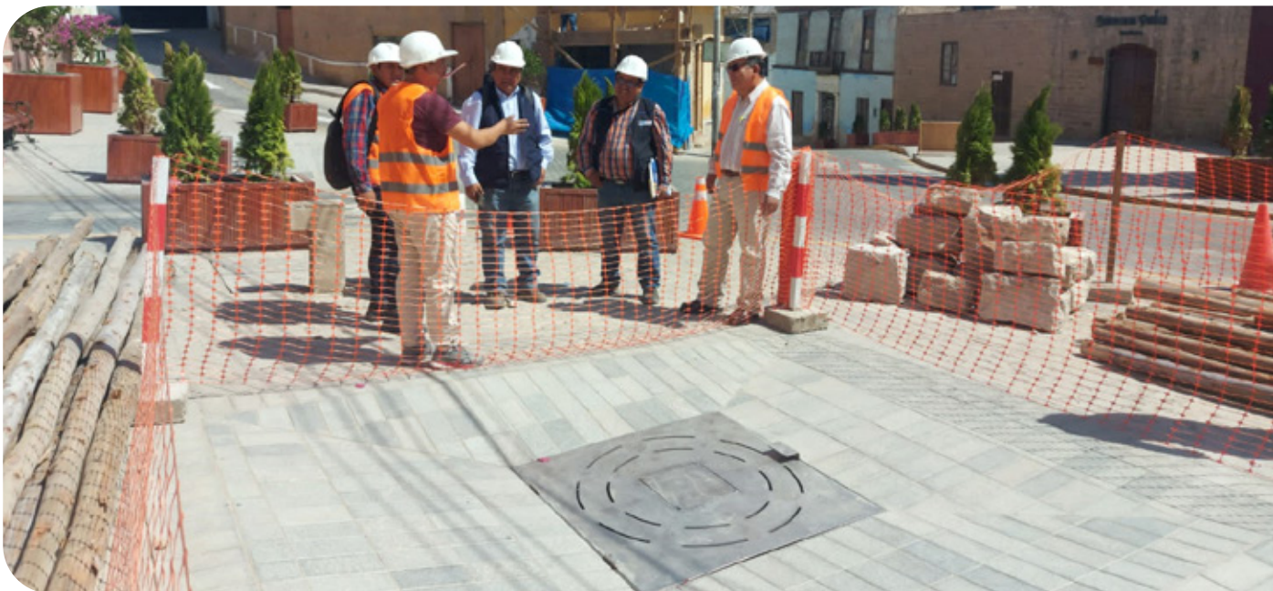
Avance de obra y juego de aguas
