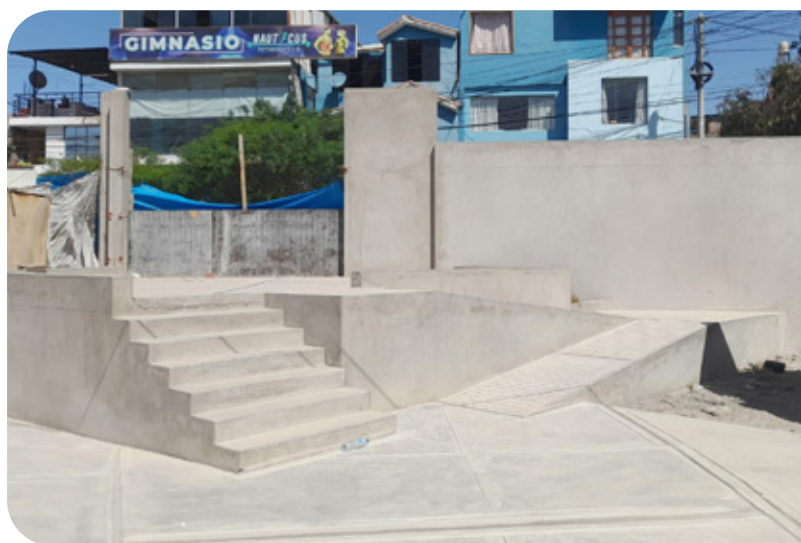
Gradería inconclusa en campo deportivo en construcción
