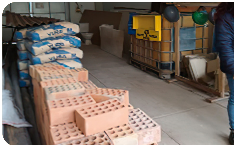
Almacén de la obra
