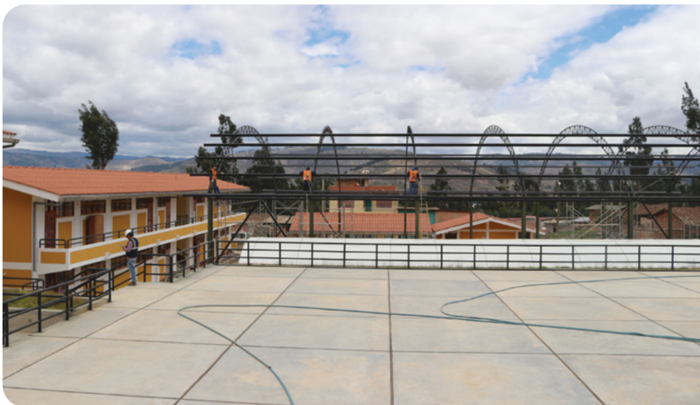
Obra paralizada para ajustar metraje de construcción de losa deportiva
