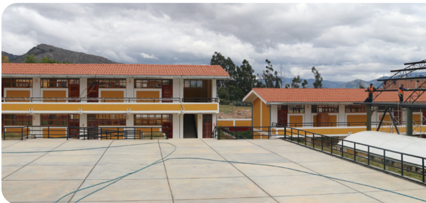
Avance de la obra
