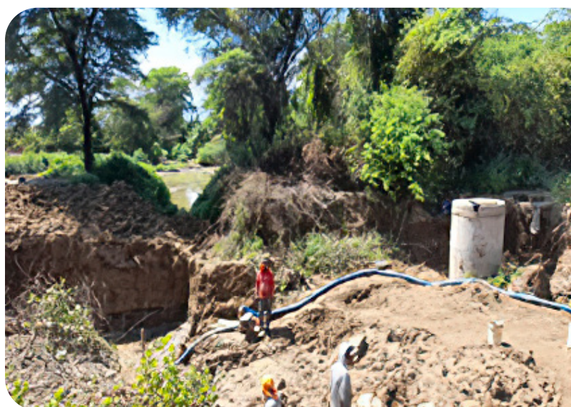
Obreros realizando bombeo de aguas estancadas
