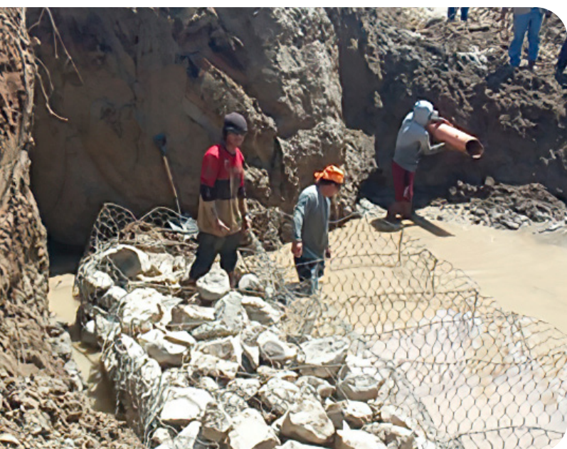
Obreros construyendo gaviones de piedras
