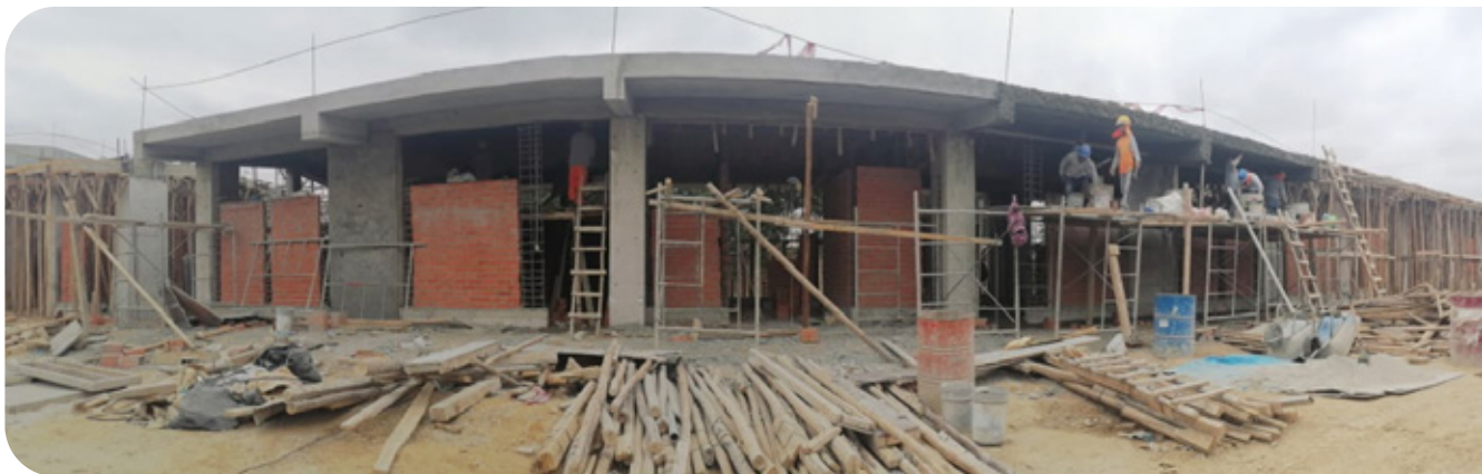
Construcción de aulas de educación inicial
