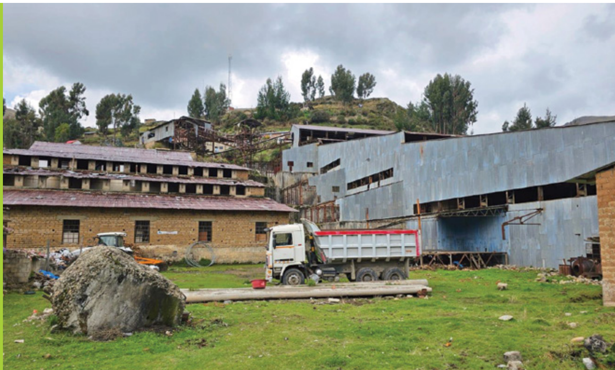
Imagen 8. Ingenio minero abandonado en la década de 1950, Progreso (fotografía: Arturo Mendieta Navarro; Progreso, diciembre de 2024)
